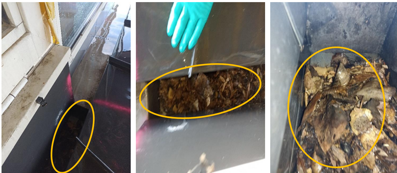
Bouchon important de feuilles dans le chéneau encastré.
