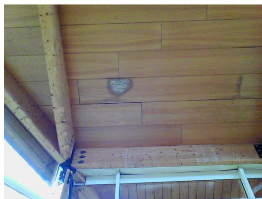
Infiltrations et ruissellement constatés sur la zone de dommages 1
