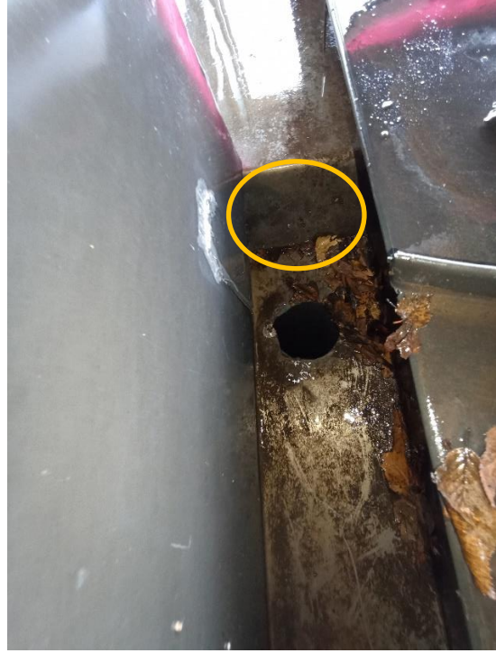
Chéneau supérieur en recouvrement.
