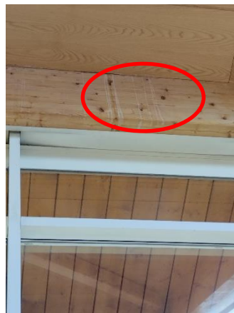
Infiltrations et ruissellement constatés sur la zone de dommages 1
