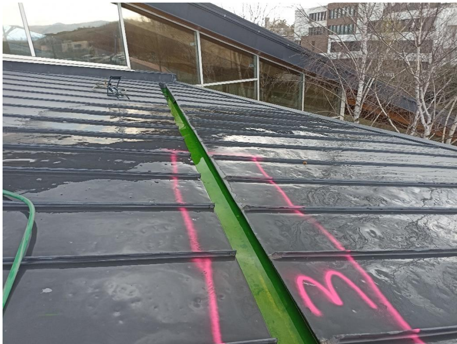
Obturation et mise en charge colorée du chéneau.
