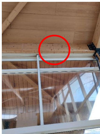
Infiltrations et ruissellement constatés sur la zone de dommages 1
