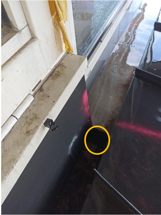
Chéneau supérieur en recouvrement.
